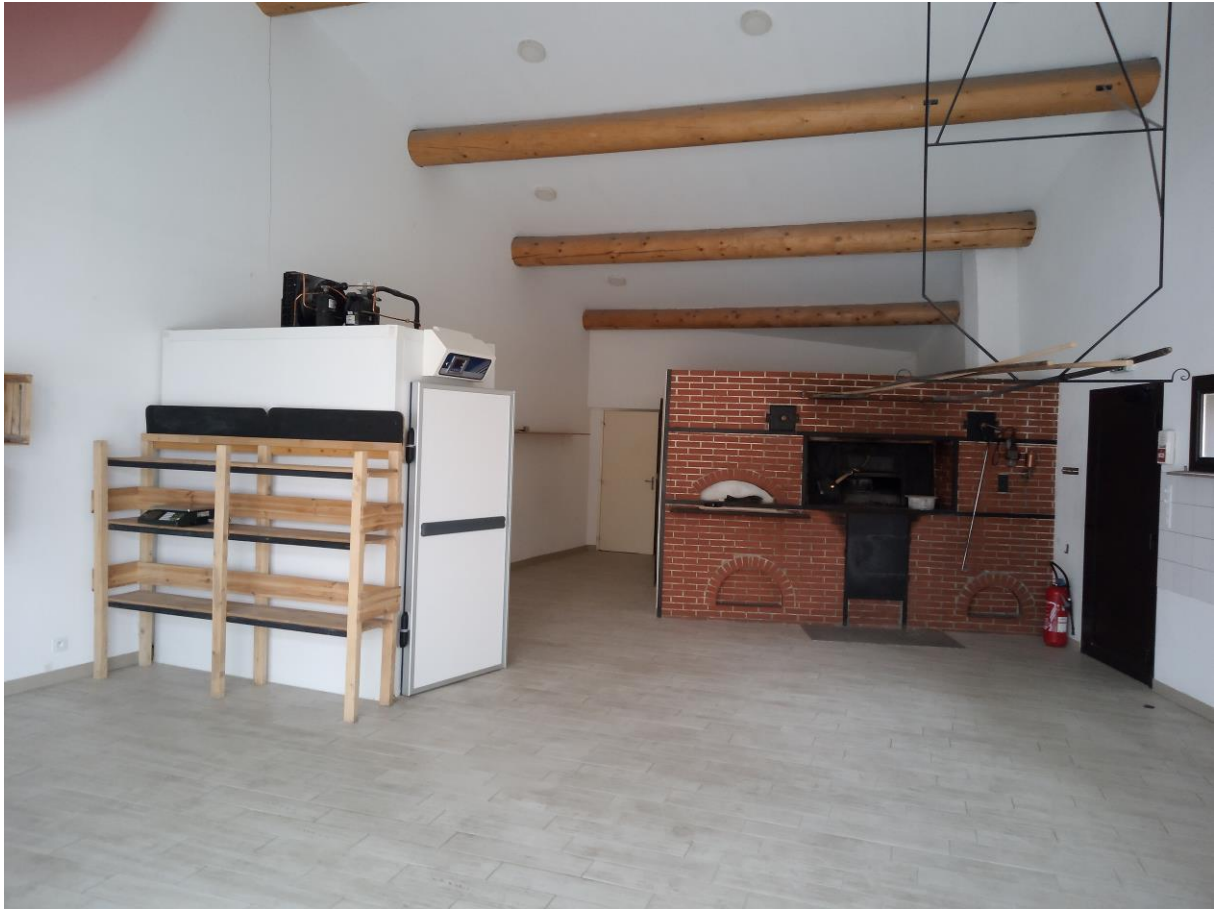
PJ1 : Vue du four et de la chambre de fermentation
